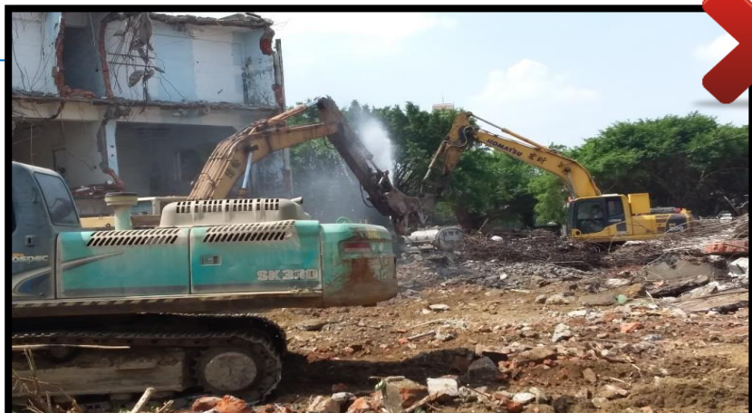
灑水但結構體未包覆防塵網(布) (缺失記點4點)
