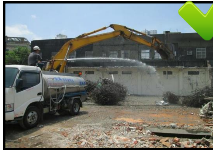
拆除作業進行時，配合加壓噴灑水
