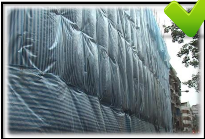
拆除結構體外包覆防塵布
