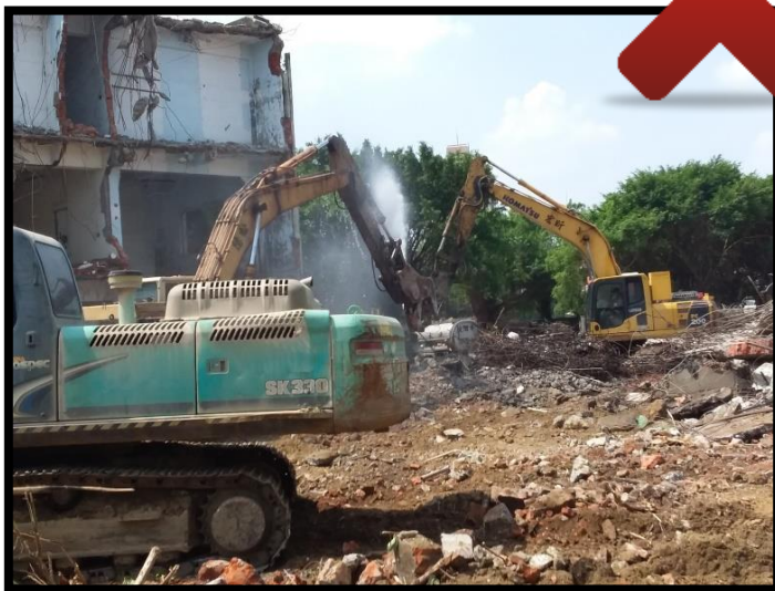
結構體未包覆防塵網(布) (缺失記點4點)
