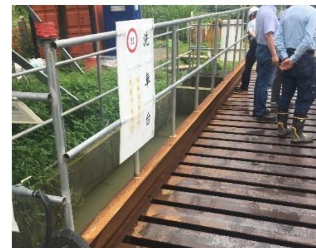
(2)廢水處理設備 (3)告示牌
