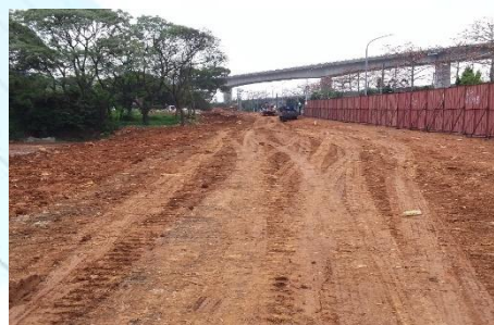
未設置防制措施
