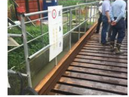
(2)廢水處理設備 (3)告示牌
