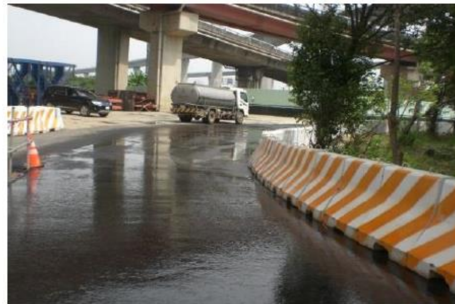
(D) 裸露區域鋪設瀝青混凝土
