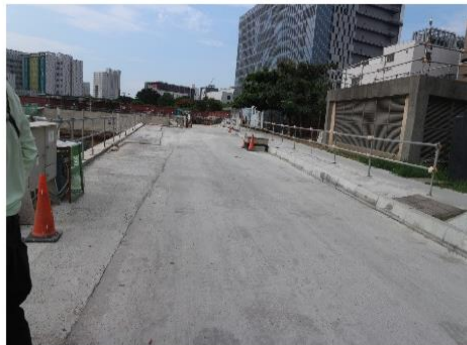
(B) 車行路徑鋪設混凝土
