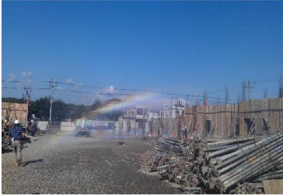
(K) 裸露區域以灑水車灑水
