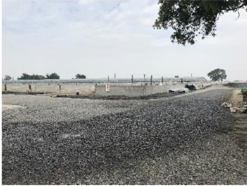
(E) 裸露區域鋪設粗級配
