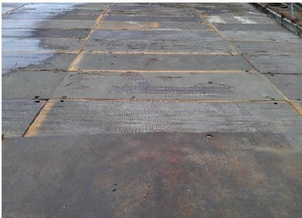
(A) 車行路徑覆蓋鋼板
