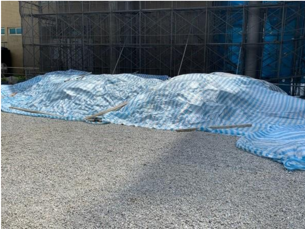
工地物料堆置覆蓋防塵布
