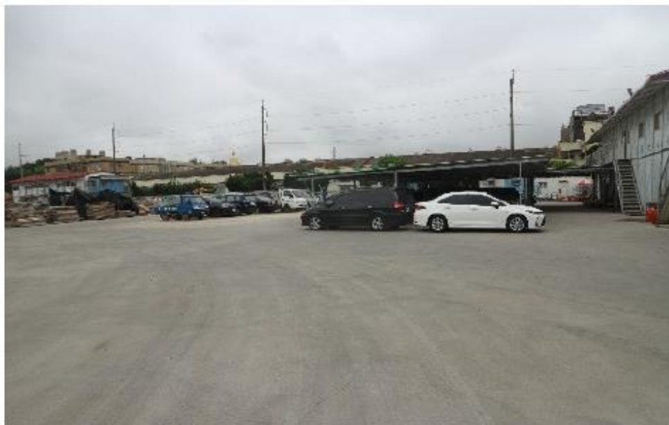
(C) 裸露區域鋪設混凝土
