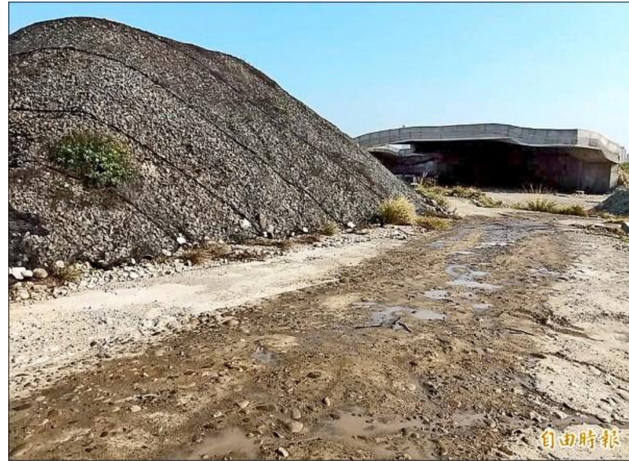
營建工地覆蓋防塵網
