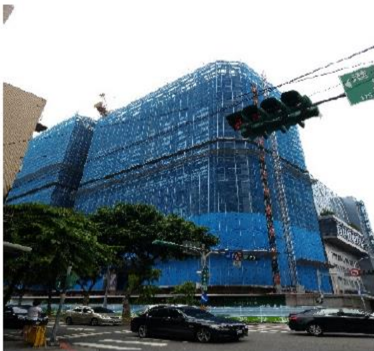
(A) RC結構體設置防塵網
