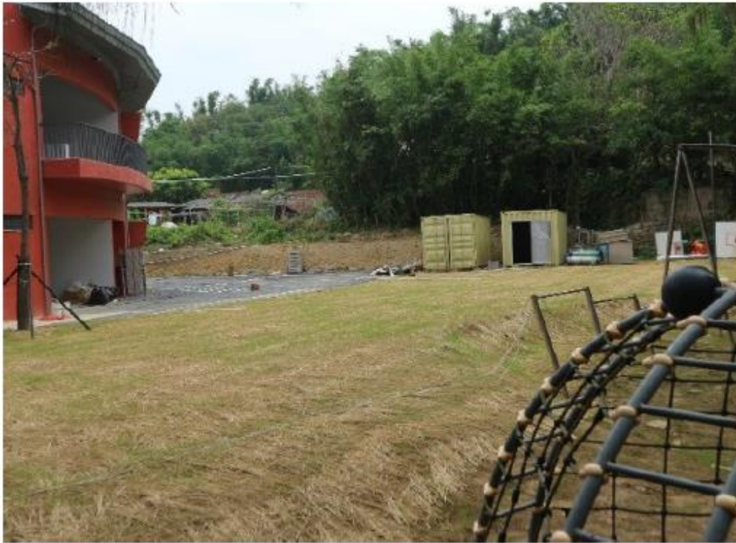
(I) 裸露區域鋪設稻草蓆
