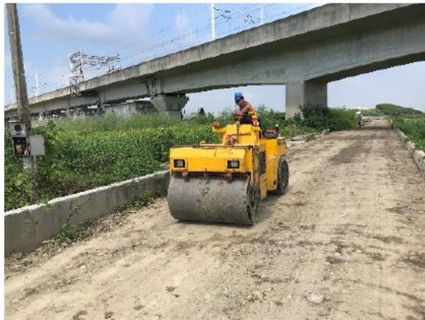
(G) 裸露區域進行壓實及灑水
