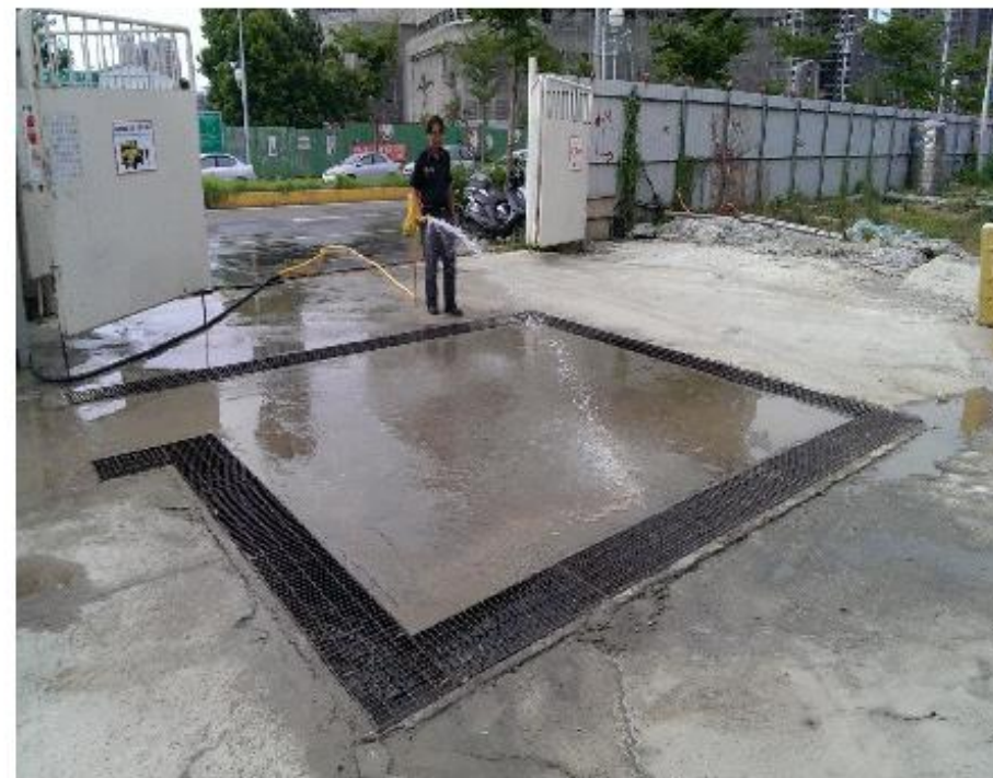
(H) 洗車廢水收集設施 (二)
