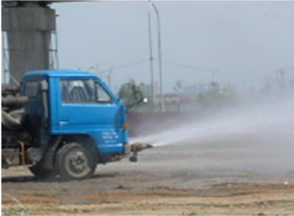
(A) 作業前灑水
