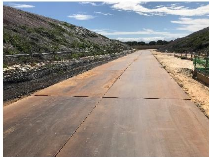
(B) 裸露區域鋪設鋼板
