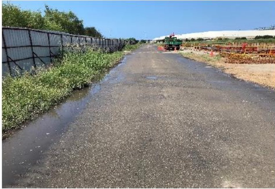
(C) 車行路徑鋪設瀝青混凝土
